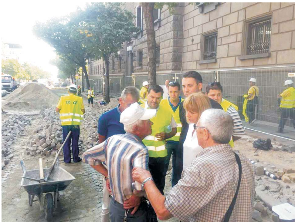
Кметът на София Йорданка Фандъкова, направи проверка как върви ремонтът на участъка от бул. „Дондуков“ между Министерския съвет и ул. „Раковски“ – на стр. 2 Снимка Пресцентър на СО
