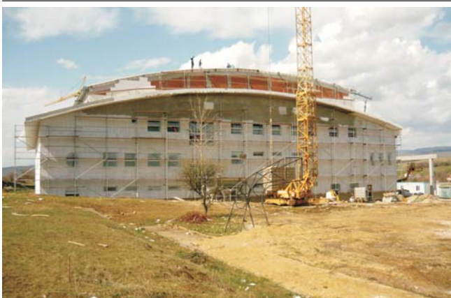
Община Горна Малина. Усилената работа кипи по изграждането на новия спортен комплекс – на стр. 11
